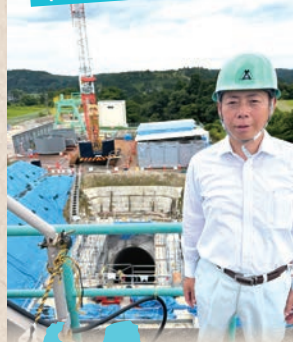
大規模改良工事(リブレース)現地視察
